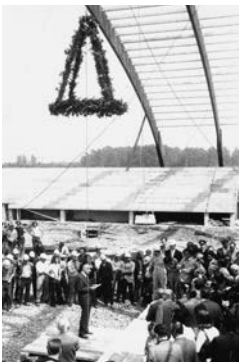
Richtfest der Eissporthalle, es spricht Hochbauamtsleiter Eugen Wesselmann, Mai 1973 (Stadtarchiv Neuss, Foto: Philipp Groß)
