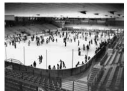
Eissporthalle Berlin, Jafféstraße, 1975 (Foto: Senatsverwaltung für Bau- und Wohnungswesen Berlin)
